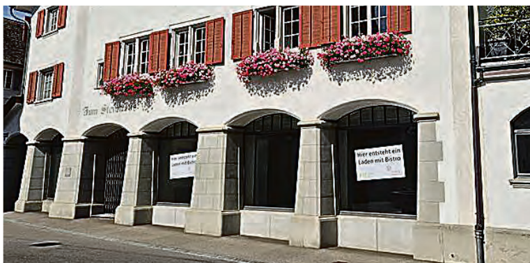
Hier entsteht das Bistro zum Steinhaus am Rathausplatz in Weinfelden.
